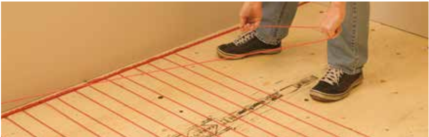
Figura 6: Instale el cable de calefacción
