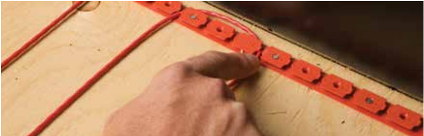
Figura 5: Instale el cable de calefacción
