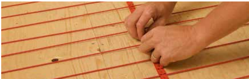
Figura 8: Instale las guías de estabilización
