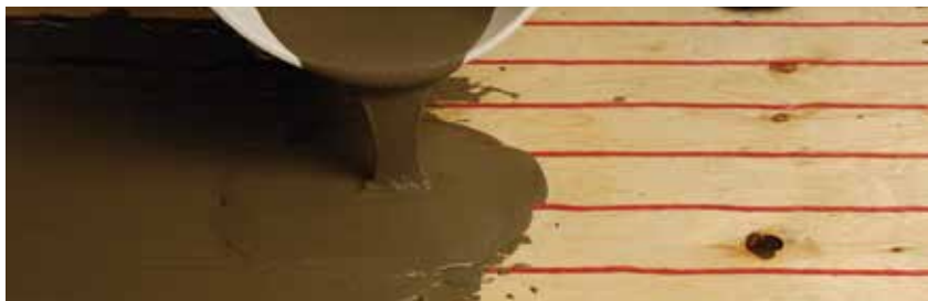
Figure 10 : méthode de la sous-finition autolissante
