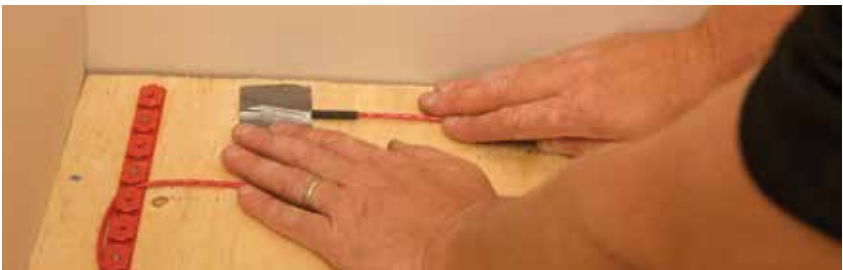
Figura 7: Asegure el sellado final
