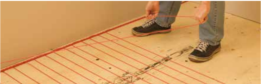
Figure 6 : installation du câble de chauffage
