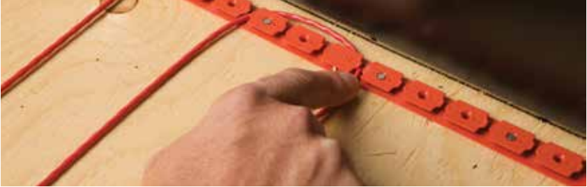
Figure 5 : installation du câble de chauffage
