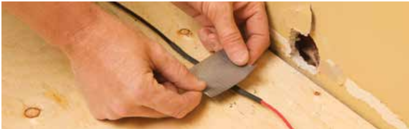
Figura 3: Asegure la guía fría al subpiso
