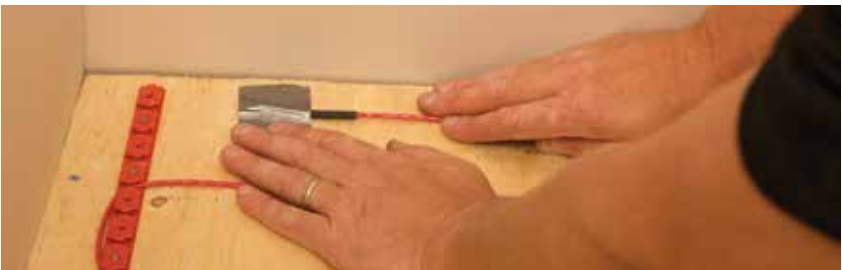
Figure 7 : fixation de l'embout protecteur
