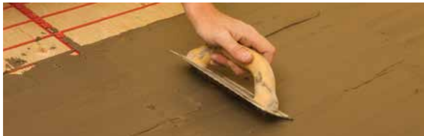
Figure 11 : méthode du ciment-colle
