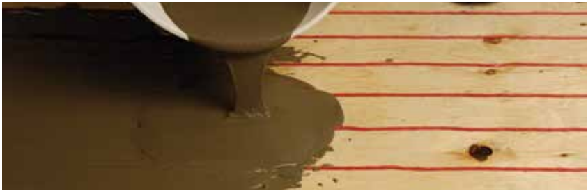
Figura 10: Método de compuesto autonivelante
