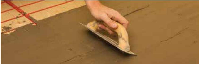
Figura 11: Método de mortero
