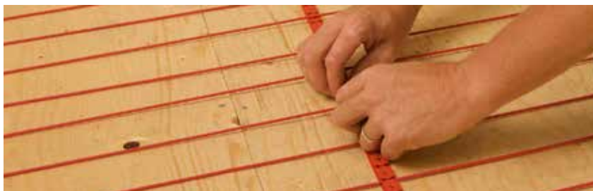
Figure 8 : installation des guides de câble de stabilisation
