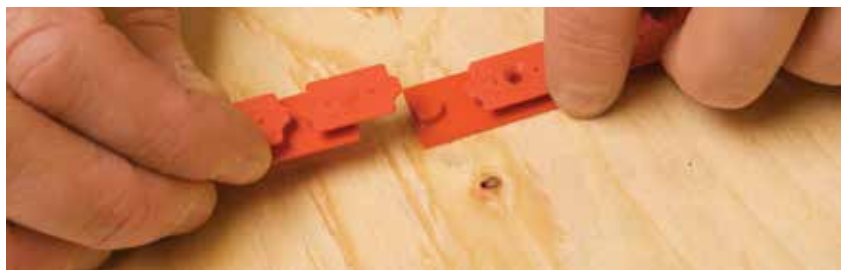
Figure 4 : emboîtement de Mapeheat Cable Guides
