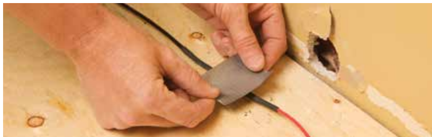
Figure 3 : fixation du conducteur froid au sous-plancher.
