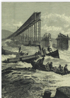
8 1年前に完成したばかりのスコットランドのティ橋が列車走行中に強風のため崩落、乗客 75 人が犠牲となった (January 10, 1880)
