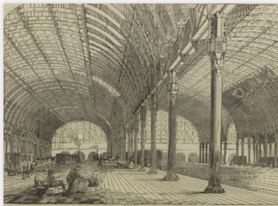
3 クリスタル・パレスの先例に倣った イサムバード・ブルーネル設計の鉄と ガラスの駅舎 (July 8, 1854)
