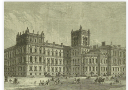
9 完成途上の外務省ビルセント・ジェームズ・パークに面する正面。設計はゴシック・リヴァイヴァルを先導した建築家ギルバート・スコット。ゴシック様式による設計案がパーマストン首相の不興を買った、外務省ビルの建築家としての名前を後世に残すために、涙を飲んでルネサンス様式で設計した (October 6, 1866)
