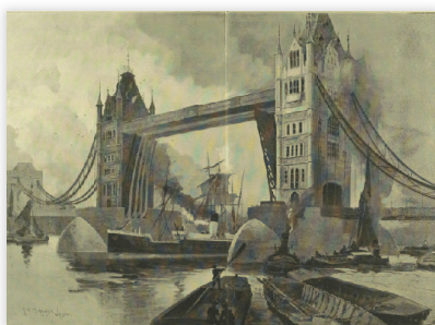
6 テムズ川兩岸の間の交通緩和を目的として 8 年がかりで建設。当時は珍しい水力を用いて開閉するバスキュール式の橋 (June 30, 1894)
