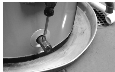
Figure 19. Vidanger l'ancien chauffe-eau
