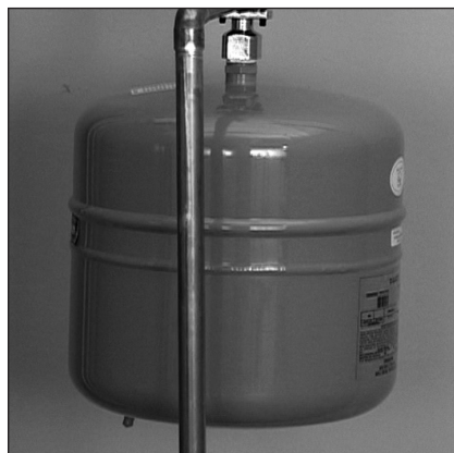
Figure 13. Le vase d'expansion protège la plomberie du domicile contre les pointes de pression.
