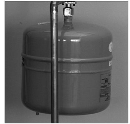
Figure 55. Le vase d'expansion doit être pressurisé à l'air à une pression égale à celle de l'arrivée d'eau du domicile.
