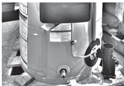
Figure 26. Pose du té d'échappement et de condensat
