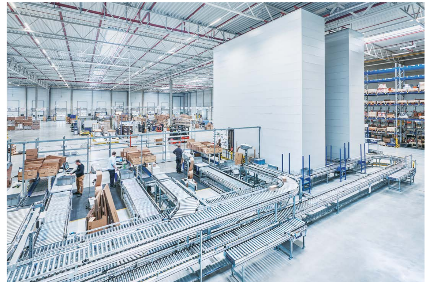
Vertical Buffer Module Kardex Miniload-in-a-Box* con conexión automática a un sistema transportador
