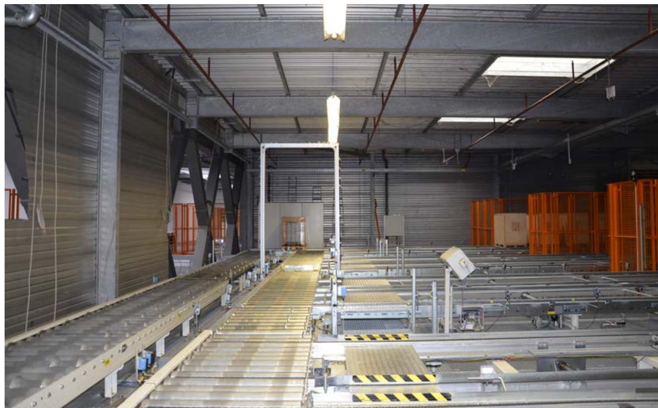
1 Um den Logistikbereich zu vergrößern, wurden der Wareneingang verlegt und die Fördertechnik entsprechend erweitert.
