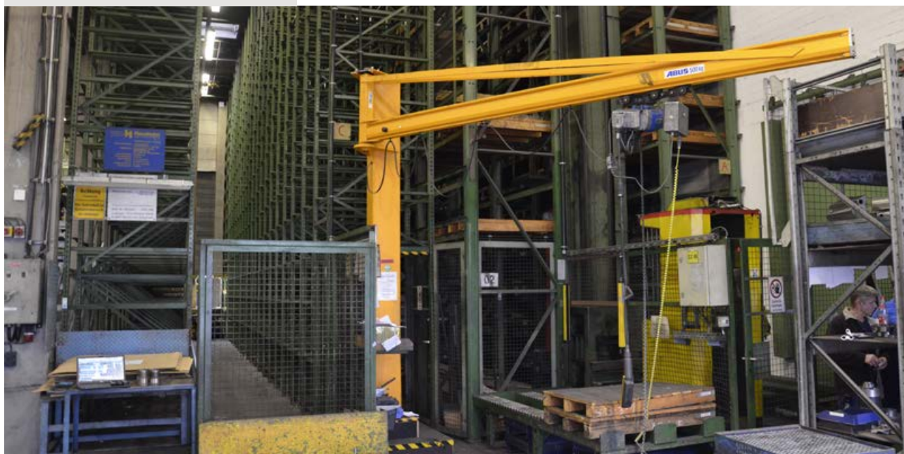
Manuelles Werkzeuglager von Hirschvogel vor der Modernisierung
