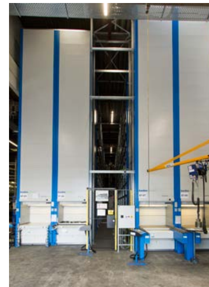
Kommissionierungsbereich 1 im neuen vollautomatischen Lager
