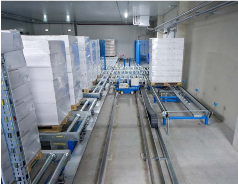
Im Warenausgangsbereich wurden neue Pufferplätze eingebaut
