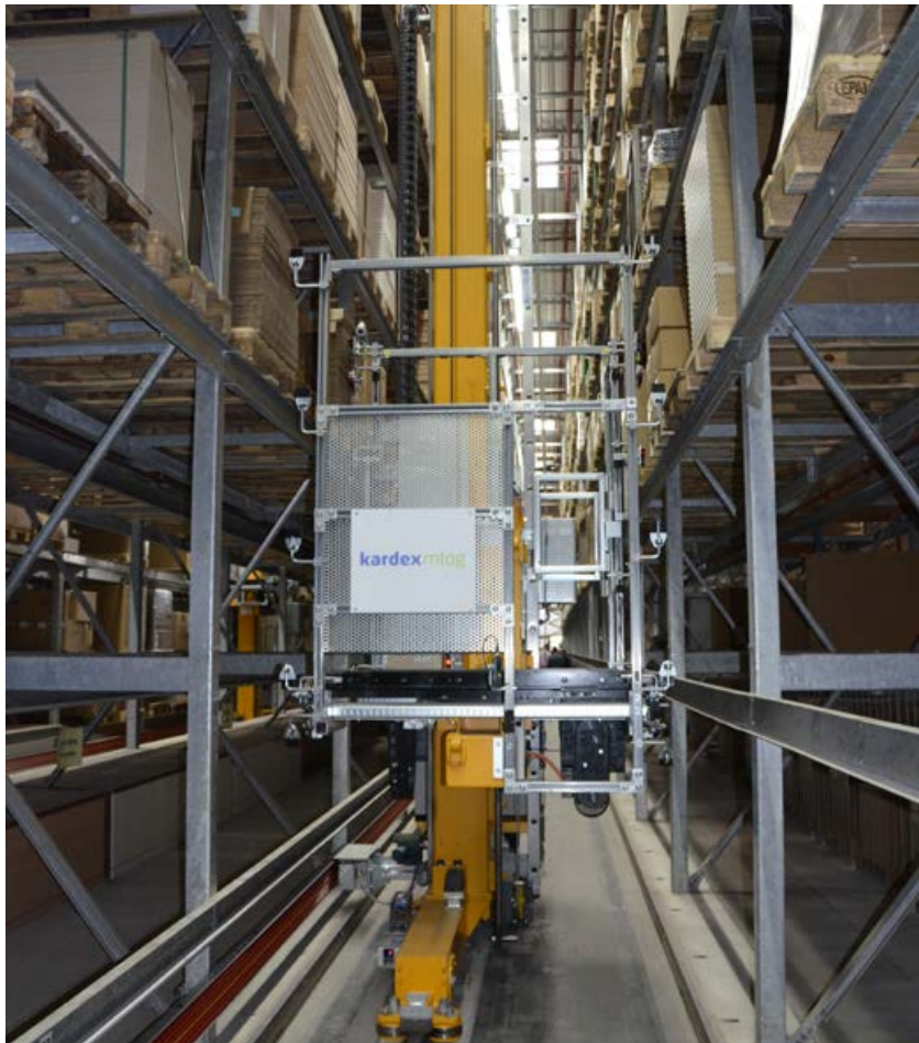
3 In den Gassen 3 und 4 des Hochregallagers wurden die Schmalgangstapler durch vollautomatische Regalbediengeräte ersetzt.
