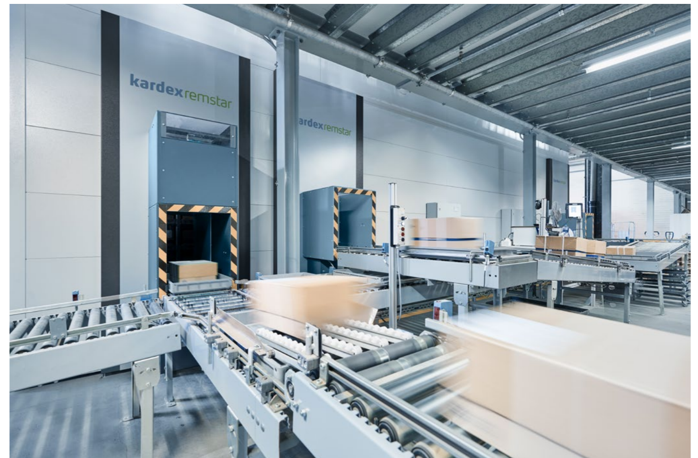
Un sistema di consolidamento degli ordini più avanzato con nastri trasportatori che gestiscono automaticamente la distribuzione dei contenitori.
