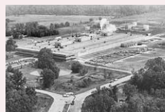
完成直後のバイク工場
